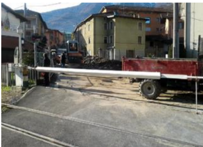
Un'altra immagine dei lavori
