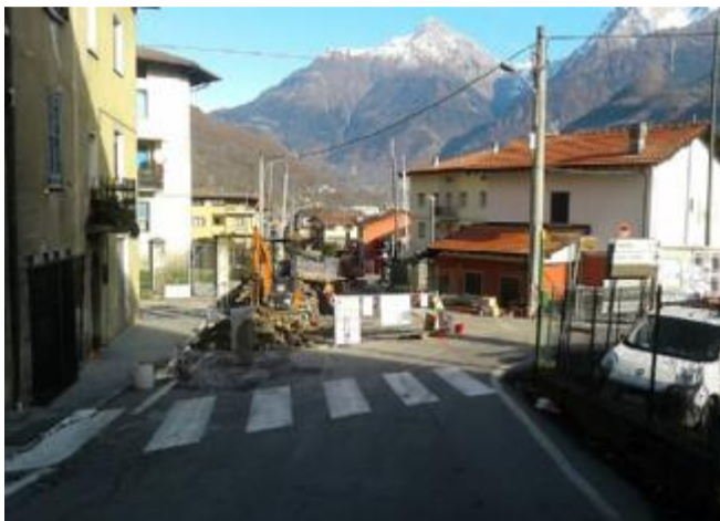
Malonno: il cantiere fognario aperto in centro
