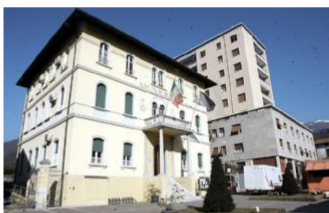
L'esterno del municipio di Sarezzo
