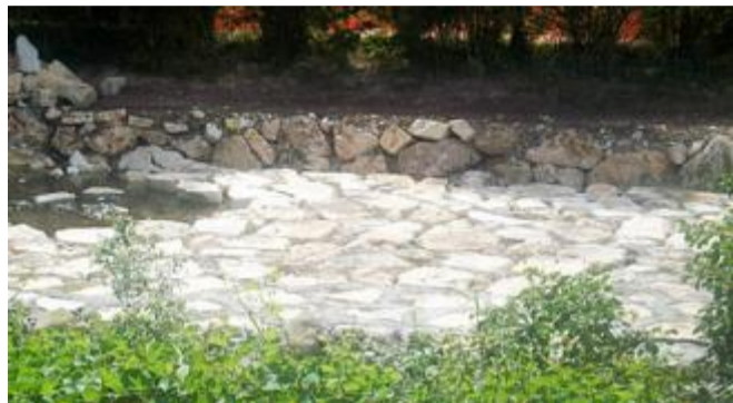
L'aspetto «estivo» delle opere fluviali realizzate a Carpeneda
